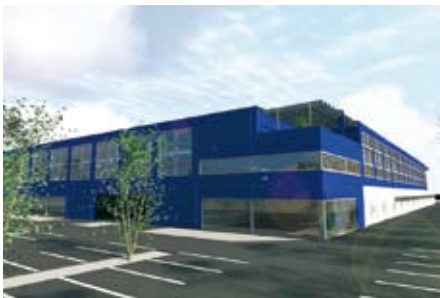
Centrum rozvoje strojírenského výzkumu Liberec, které postaví letos Výzkumný ústav textilních strojů
